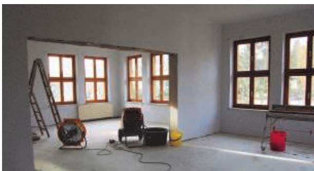
Baustelle Ostflügel März 2017
